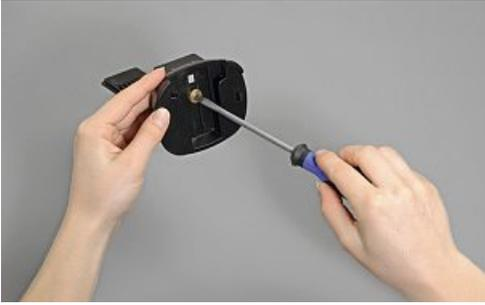
Bevestig de wandhouder met 2 schroeven op de door u vastgelegde plaats voor de camerahouder. Let erop dat er naar boven voldoende plaats is om de camerahouder aan te brengen. Als u de wandhouder stevig tegen de wand heeft geschroefd, plaatst u de camerahouder aan de hand van afbeelding 6 op de wandhouder.
